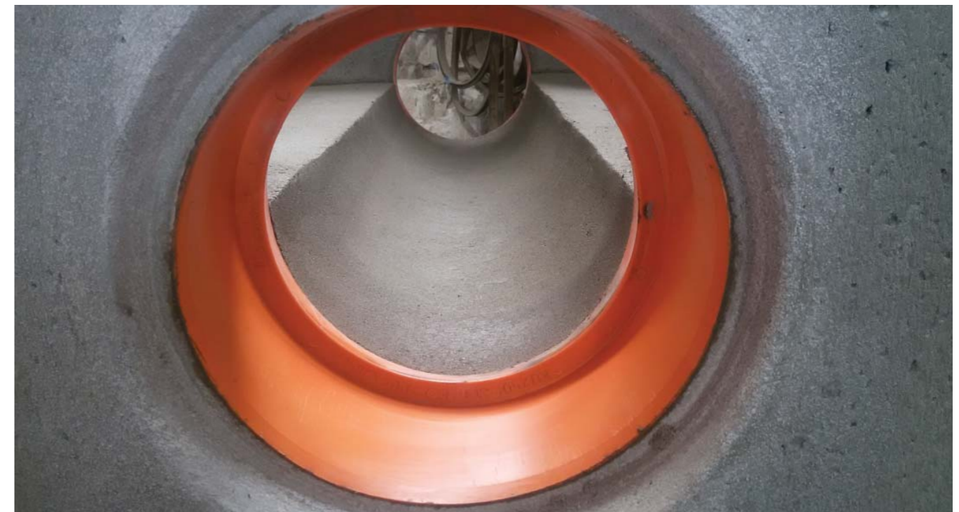
INTEGROVANÁ ŠACHTOVÁ VLOŽKA BEZ TĚSNĚNÍ DLE TYPU POTRUBÍ
