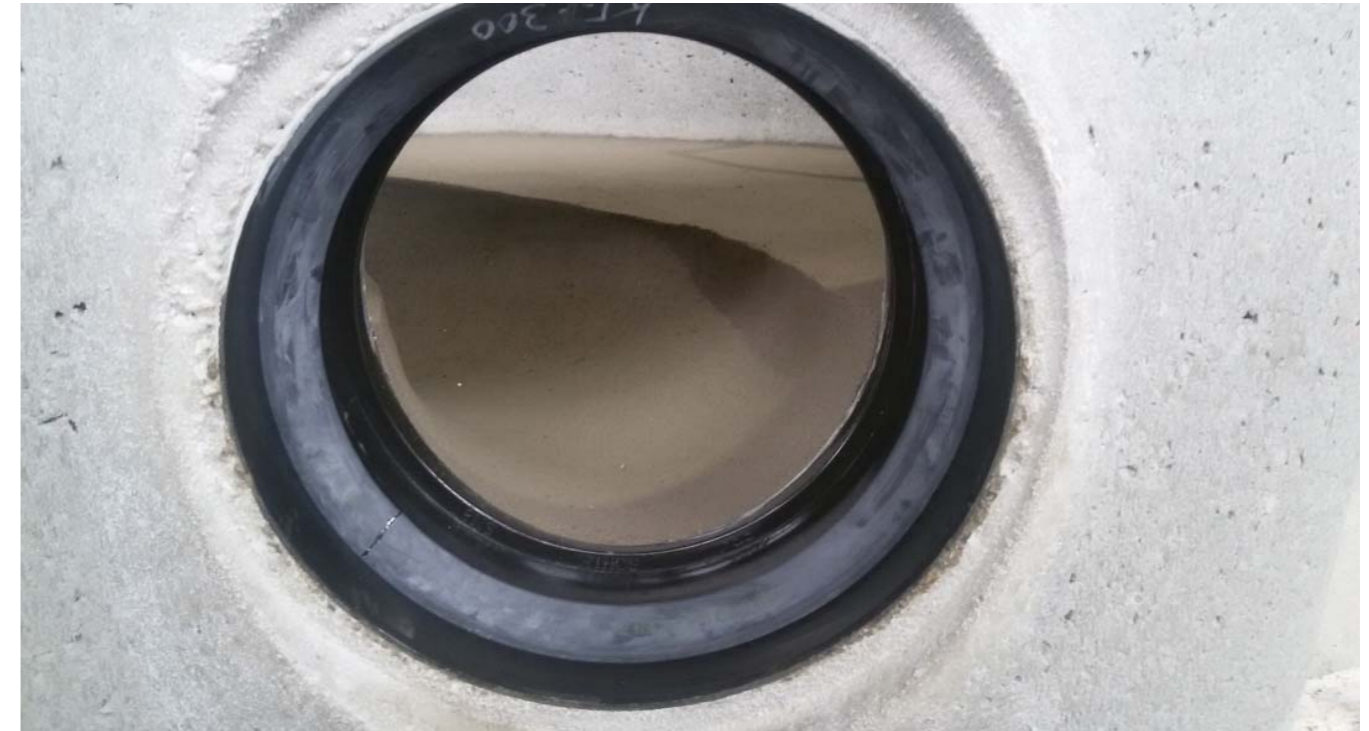
INTEGROVANÁ ŠACHTOVÁ VLOŽKA BEZ TĚSNĚNÍ DLE TYPU POTRUBÍ
