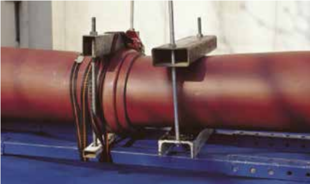
Zkouška těsnosti EN 1277
